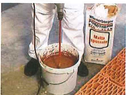
Miscelazione della Malta Speciale Porotherm (fornita in sacchi da 25 kg) con 9-11 litri d'acqua per sacco.
