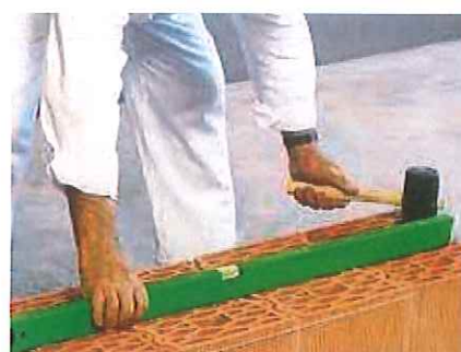
Realizzazione del primo corso di blocchi con l'ausilio della livella e di un martello di gomma per controllare l'orizzontalità dei corsi.
