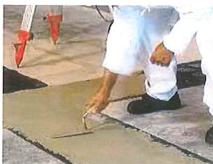
Realizzazione del massetto di livellamento (2 cm c.a.) perfettamente a bolla per la posa in opera del primo corso di blocchi.
