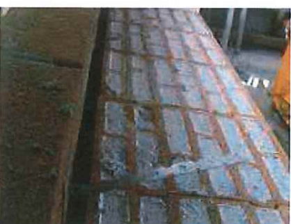
Connessione del blocco in laterizio riempito di perlite al telaio a vista attraverso l'utilizzo degli ancoraggi.
