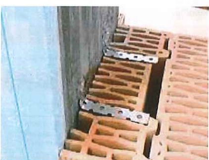
Connessione del blocco rettificato al telaio in c.a. tramite ancoraggi.
