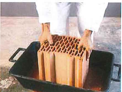
Posa in opera dei blocchi per immersione, intingendo i blocchi all'interno di una bacinella.
