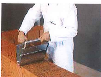
Realizzazione del giunto di malta sottile con l'apposito rullo stendimalta.
