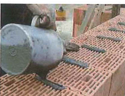
Riempimento della tasca nei blocchi rettificati per muratura portante.
